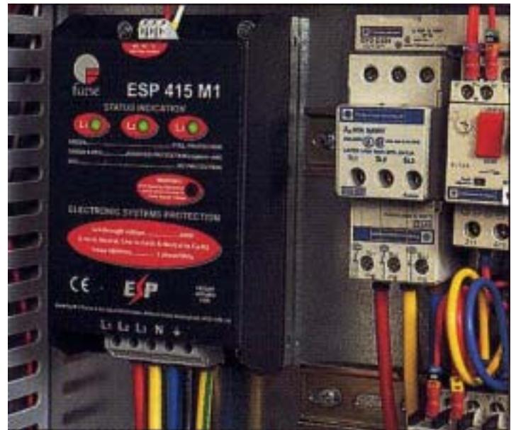
電源盤内への取り付け例
